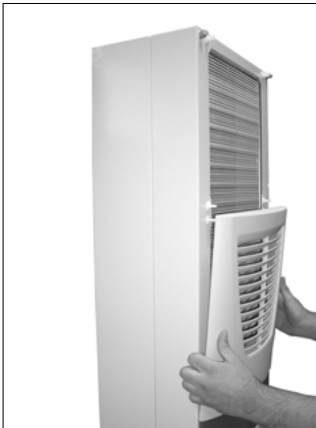
Fig. 61: Remove the top louvred grille (3)
